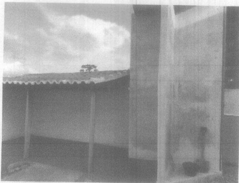
Imagem 03 – Execução de contrapiso, cobertura cerâmica e alvenaria (garagem motos, base caixa d'água).
