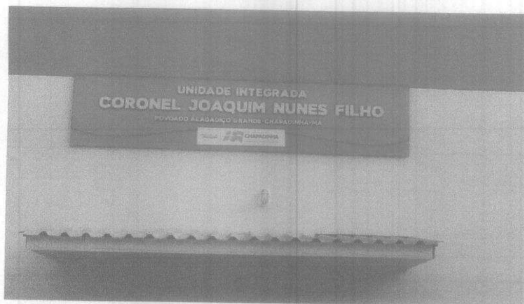
Imagem 04 – instalação de placa ACM na fachada
