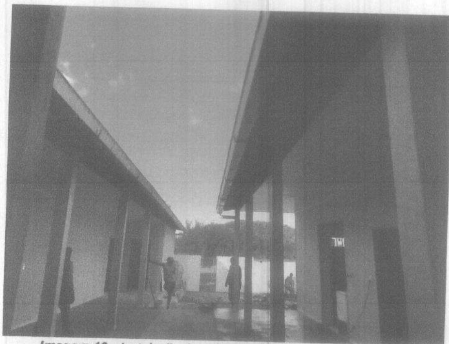
Imagem 10 – instalação da calha em chapa de aço galvanizado. Fonte: Autora – 2022
