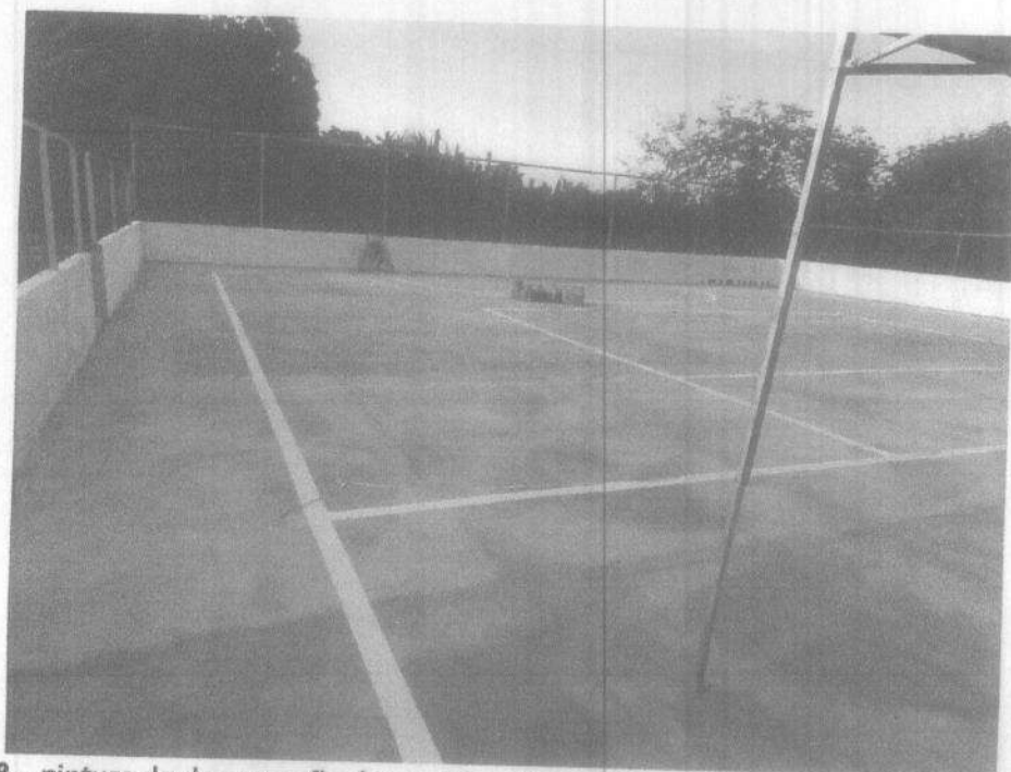
Imagem 08 – pintura de demarcação de quadra poliesportiva com tinta epóxi, E= 5cm, aplicado de forma manual.
