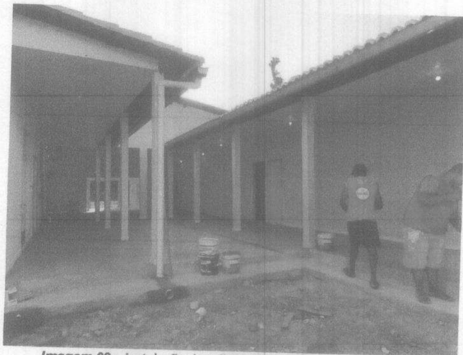
Imagem 09 – instalação da calha em chapa de aço galvanizado. Fonte: Autora – 2022
