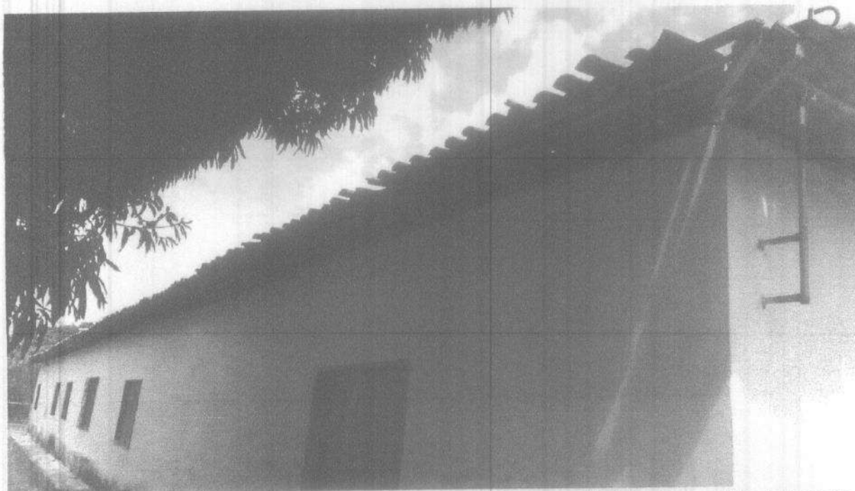
Figura 02: fachada lateral da unidade escolar - avaria na impermeabilidade da superfície da fachada decorrente da perda do desempenho da pintura.
