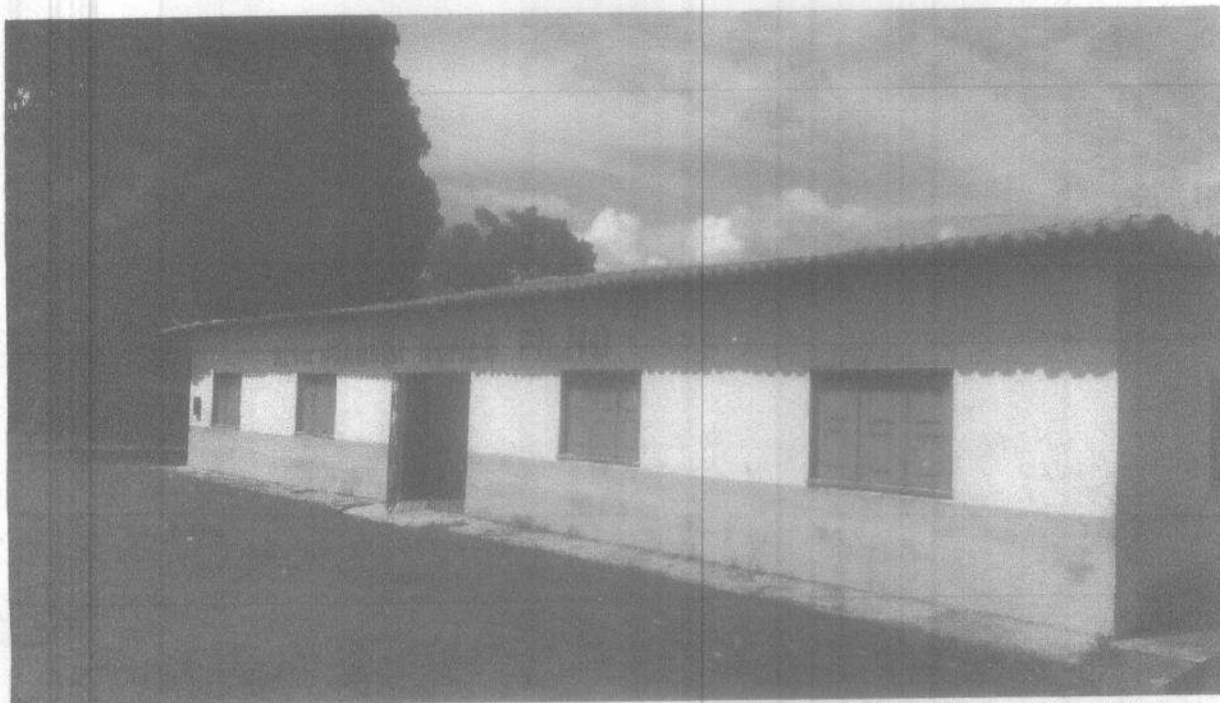
Figura 01: fachada principal da unidade escolar - avaria na impermeabilidade da superfície da fachada decorrente da perda do desempenho da pintura.
