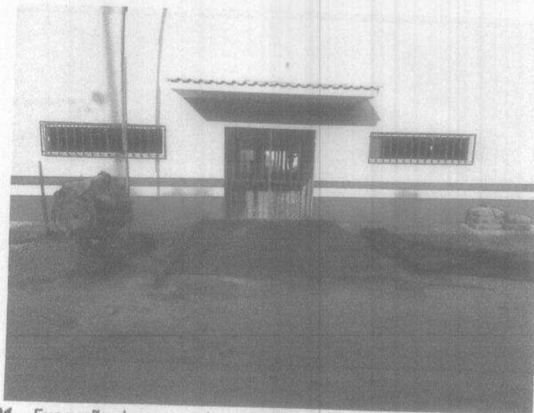
Imagem 01 – Execução da rampa de acessibilidade e cobertura metálica na fachada. Fonte: Autora – 2022
